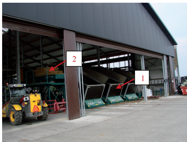
Fot. 5. Kuchnia paszowa usytuowana na przedłużeniu obory z widocznymi zasobnikami na pasze objętościowe: 1 – zasobniki na kiszonkę, 2 – zasobnik na słomę (fot. A. Kaczor)
