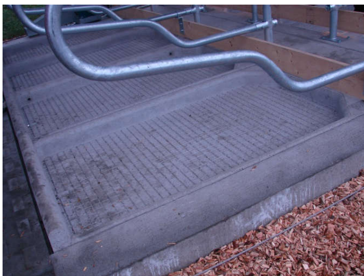
Fot. 2. Posadzka legowiska boksów wykonana z gotowych elementów Phot. 2. Lying box flooring from ready-made elements
