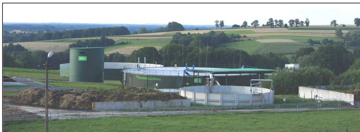
Agrobiogazownia w Kostkowicach
