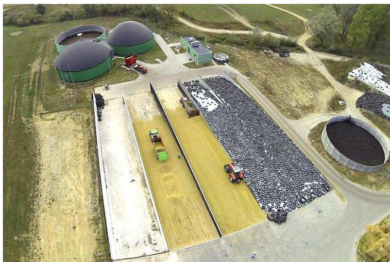
Biogazownia w ZD IZ PIB Sp. z o.o. w Odrzechowej
