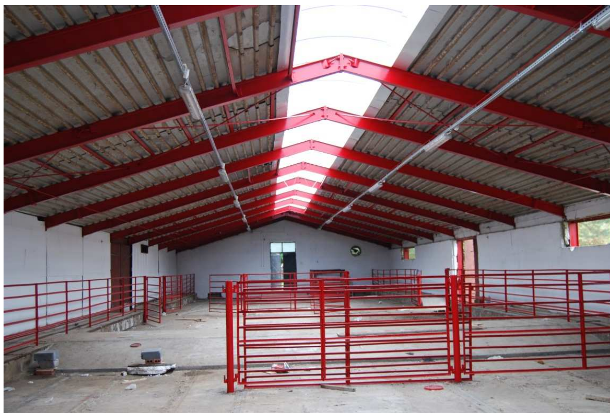
Fot. 2. Prace remontowe – wygradzanie sektorów, montaż świetlików Fig. 2. Renovation work – fencing off sections, installation of skylights (fot. J. Fijał)
