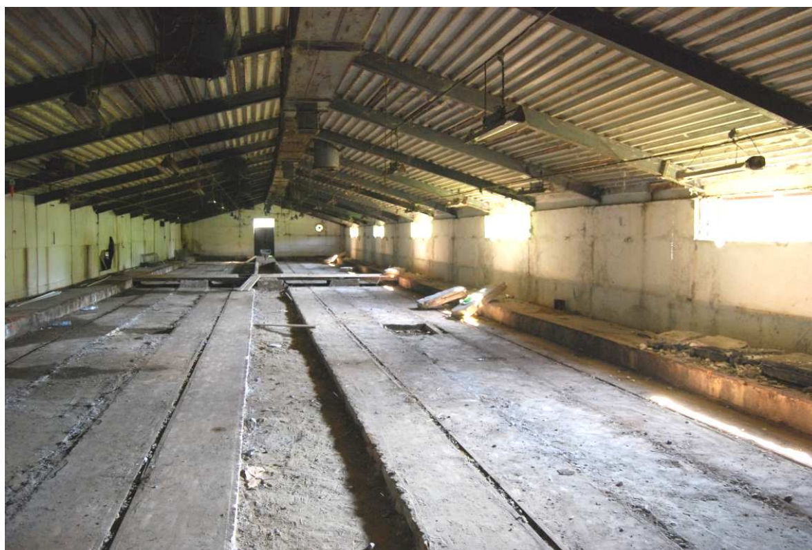
Fot. 1. Opuszczony budynek po dawnej fermie króliczej – stan przed remontem Fig. 1. Abandoned building of an old rabbit farm – state before renovation (fot. J. Fijał)
