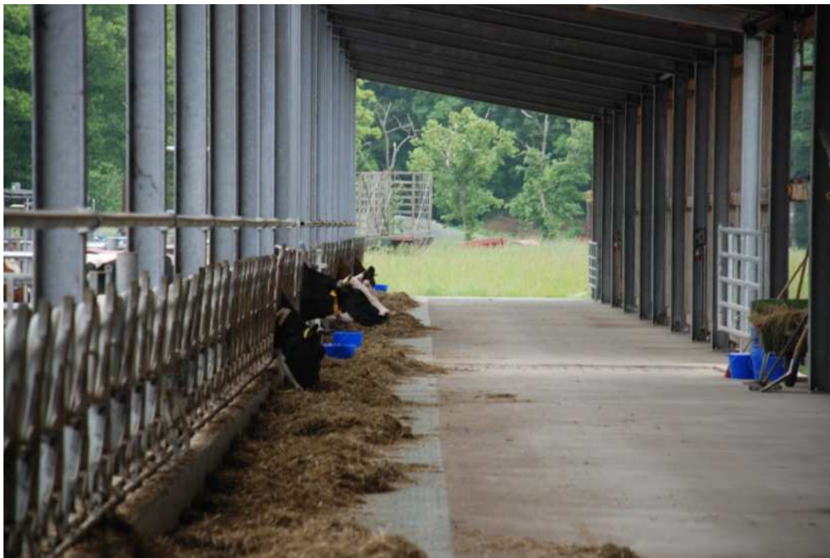
Fot. 5. Półotwarta, ekologiczna obora wolnostanowiskowa na 120 krów. Na lewo od korytarza paszowego widoczna odkryta część wybiegów – FAL Trenthorst Fig. 5. Semi-open, organic free-stall barn for 120 cows. The open part of the outside area visible to the left of the feed alley – Federal Agricultural Research Centre Trenthorst (fot. J. Walczak)
