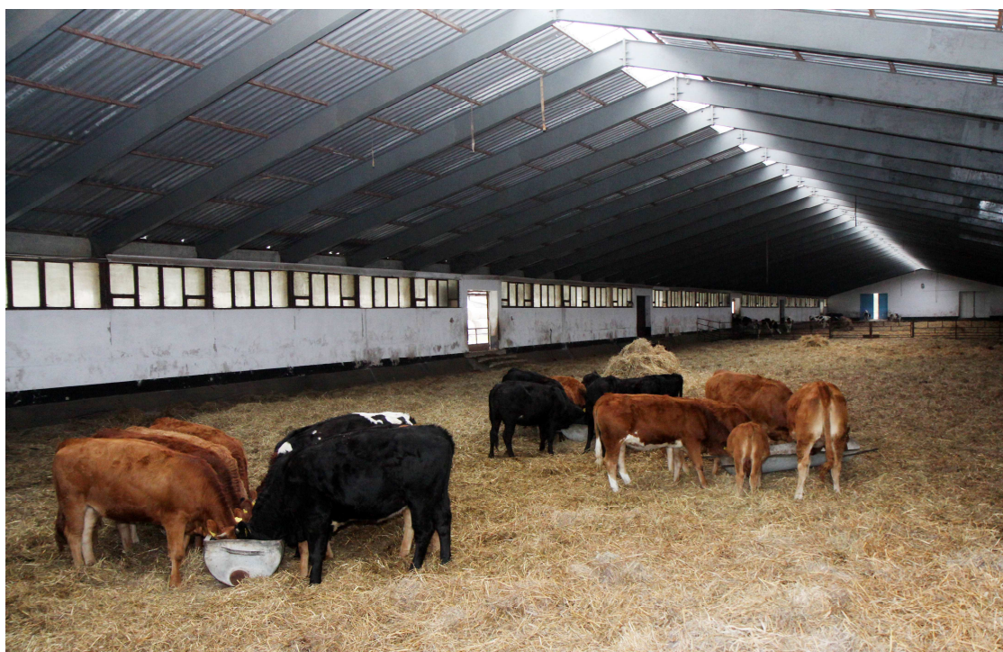
Budynek po remoncie bez wydzielonych sektorów Renovated building without separated areas
