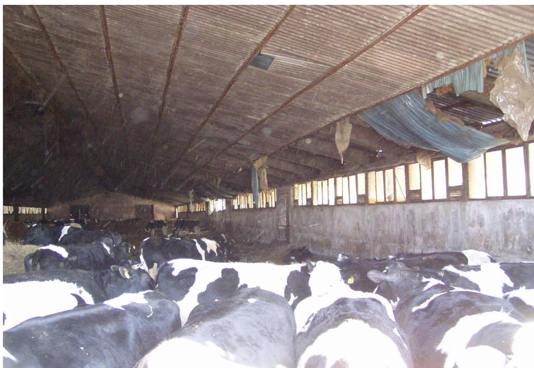
Budynek przed kapitalnym remontem Building prior to extensive renovation
