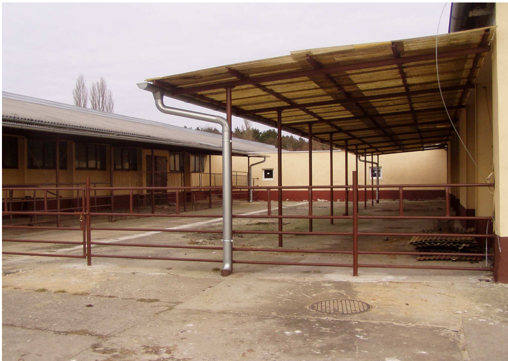
Wewnętrzny okólnik z miejscem na zabiegi i korekcję racic Indoor yard with an area for handling procedures and claw correction
