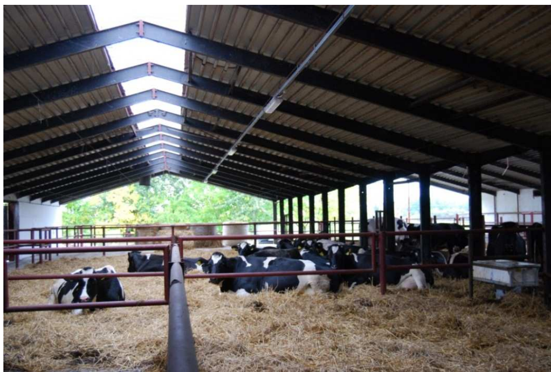
Fot. 4. Zasiedlony budynek po modernizacji Fig. 4. Modernized barn with animals
