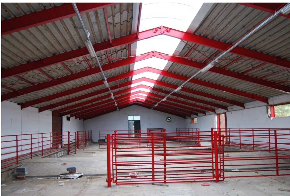
Fot. 3. Dalsze prace remontowe (wygradzanie sektorów, montaż świetlików) Fig. 3. Further repair work (fencing off the barn areas, installation of skylights)
