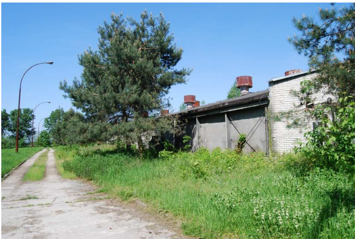
Fot. 5. Otoczenie obory przed remontem Fig. 5. Surroundings of the barn prior to renovation
