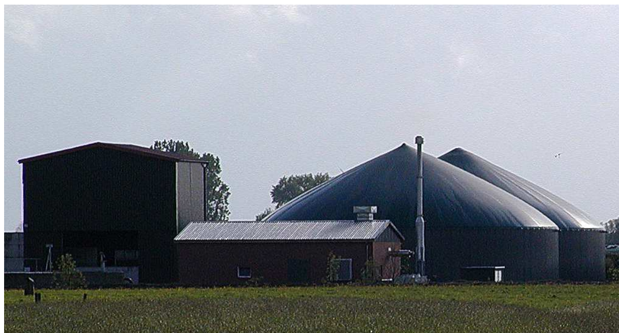
Biogazownia – instalacja służąca do produkcji biogazu z biomasy roślinnej i odchodów zwierzęcych Biogas plant – installation for biogas production from plant biomass and animal excrement
